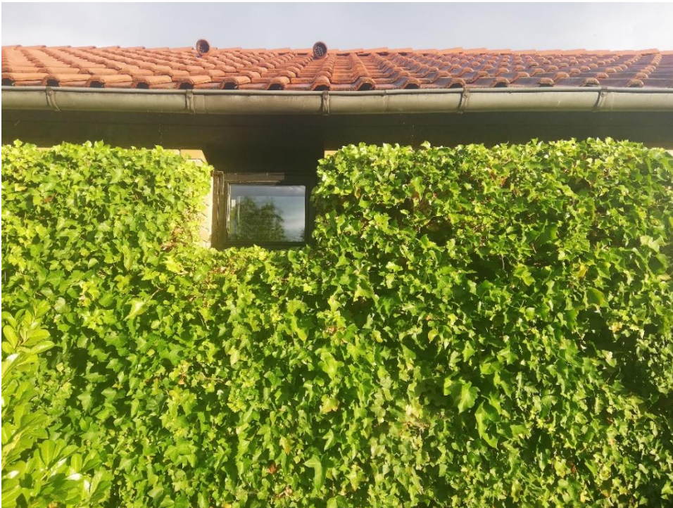
Beplantning med vedben - hus nr.102
